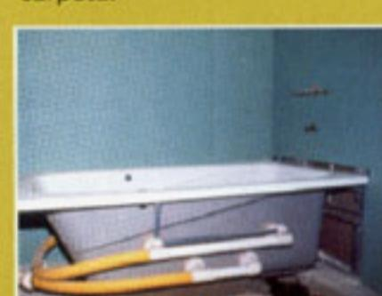
Sobre la superficie de las paredes se coloca un refuerzo de Solera de 70mm sobre el cual se apoyará la bañera. Se presenta la bañera, conectando la sopaña y realizando una prueba.
