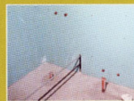
Luego se realiza el asiento de mortero y se construye el frente de bañera con Media Pared con estructura de 35mm y **Placa Durlock® Resistente a la Humedad**, apoyando la placa en la carpeta.
