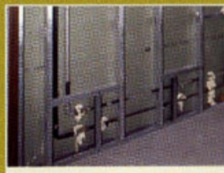
Para fijación de equipamiento pesado, (mesadas, sanitarios tipo ménsula, etc.), se deben prever refuerzos realizados en chapa y calculados según el peso a soportar.
