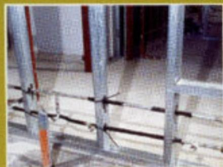
Las instalaciones quedan sujetas a la estructura sin que exista posibilidad de movimientos, en especial griferías, cuadros de ducha, etc. Las cañerías se fijan en todo su recorrido, sin permitir movimientos por golpe de ariete o vibraciones.
