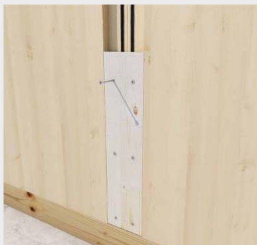
^ Fijación de paredes de CLT con tornillos HBS diámetro 6 mm.
