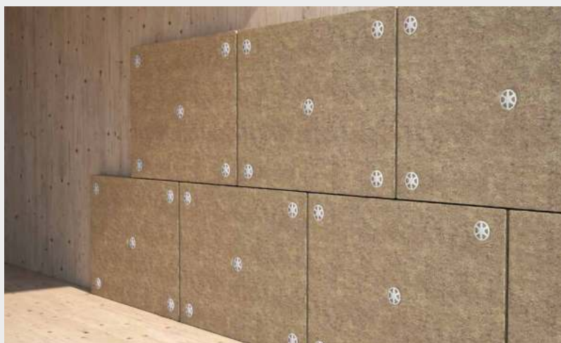
^ Fijación de paneles de aislante para pared con THERMOWASHER y HBS de 8 mm de diámetro.
