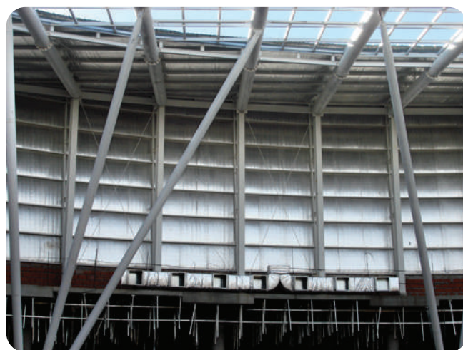
Utilización Filtro Tensado Alu en cubierta y cerramiento vertical.
