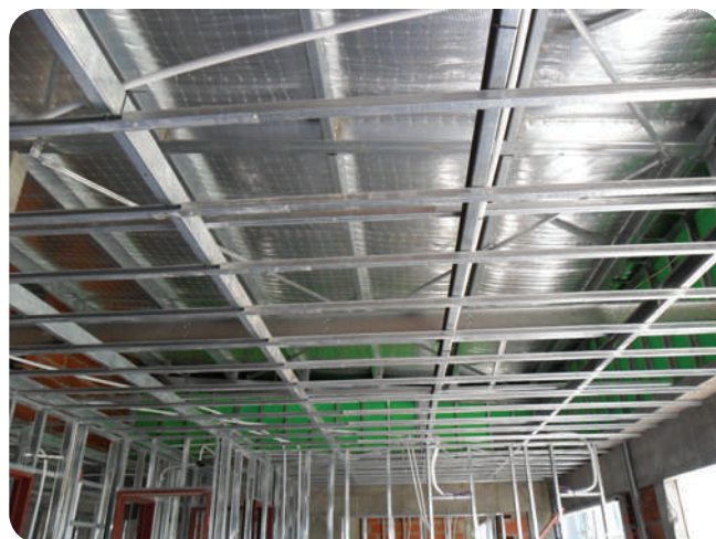
Utilización Filtro Tensado Alu en cubierta.
